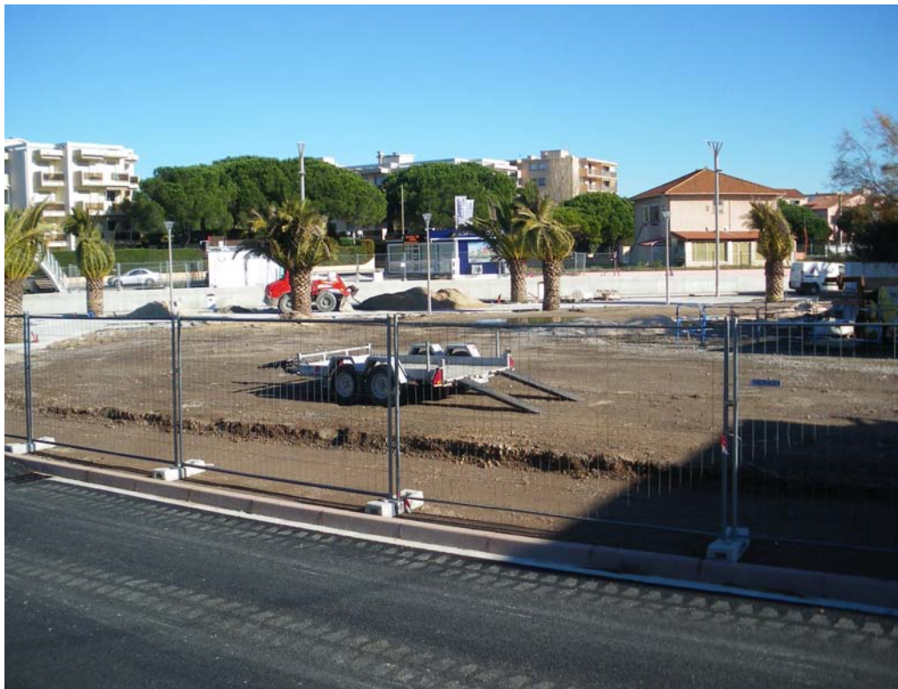
Partie nord-ouest du lot n° 9
