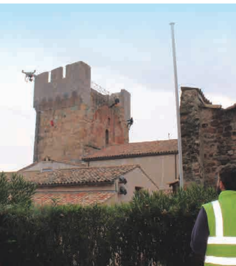
Les cordistes voltigeant sur les façades et le géomètre effectuant ses photos par drone.
