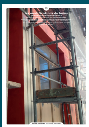
13 modifications de baies
