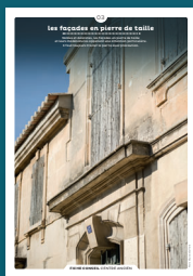
03 les façades en pierre de taille
