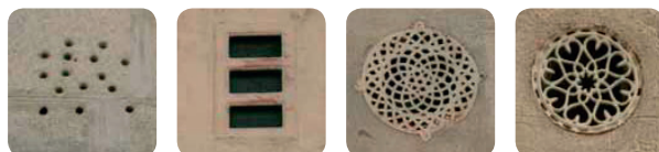
Grilles de ventilation intégrées dans la maçonnerie
