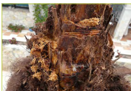
Dégâts & amas de sciure
