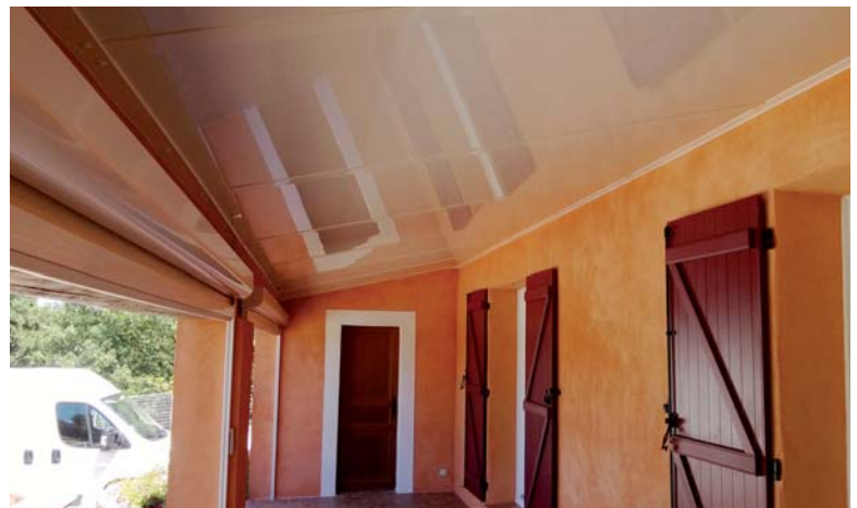
Exemple de réhabilitation qualitative réalisée dans le cadre du programme Rénover + pour une meilleure isolation thermique du plafond.
