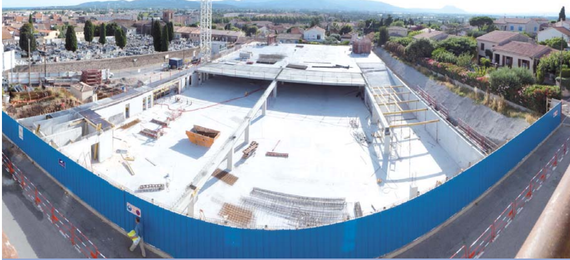
Vue panoramique du futur équipement en août dernier, au moment où la dalle du niveau supérieur était en train d'être posée. On aperçoit la future entrée du parking sur la gauche à hauteur du niveau intermédiaire, et la rampe d'accès au 3 e et dernier niveau sur la droite.
