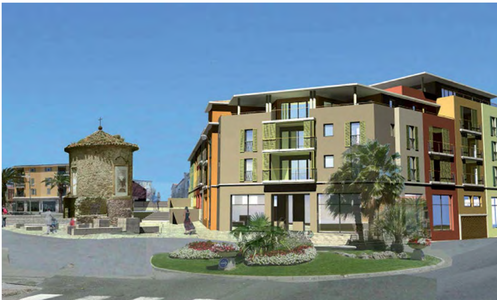
32 appartements et une surface commerciale en son pied, comprenant notamment une petite supérette : le programme “Cœur de ville” est entré dans une phase concrète ces dernières semaines avec les travaux de terrassement. La livraison de l’ensemble est prévue fin 2015, marquant ainsi le terme de la requalification de l’entrée “est” du centre historique de Fréjus, débutée en 2003 avec la démolition de l’ancienne salle des fêtes...
