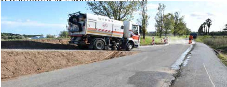
Réalisation de rampes d'accès sur les 16 km de digues du Reyran canalisé. Qui nécessitent parfois des travaux de voirie, ici un élargissement de voie rue du Montourey
