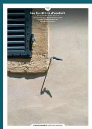
02 les finitions d'enduit
