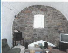
©H. Garcia, service patrimoine
