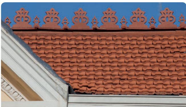
Chêneau en zinc Lambrequin de rive en zinc Lambrequin d'égout en zinc
