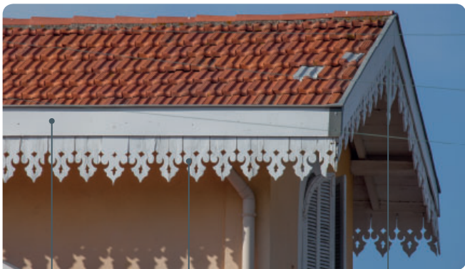
Chêneau en zinc Lambrequin de rive en zinc Lambrequin d'égout en zinc
