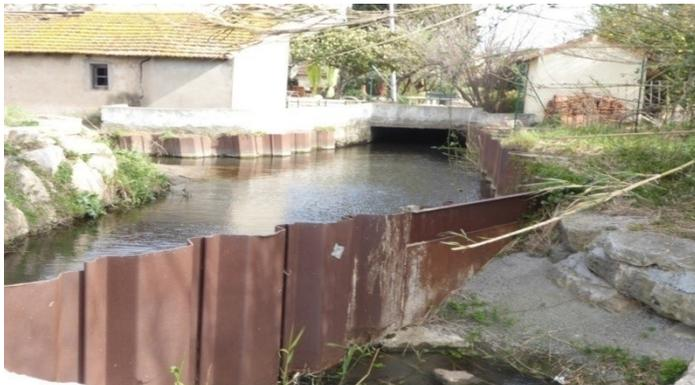
2.73 La mise en place d'une conduite gravitaire de délestage du Béal par la rue du port Romain jusqu'au PR de port Fréjus .
