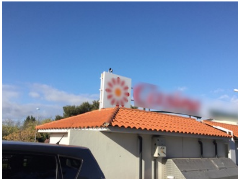
Enseigne sur toiture – Fréjus, avril 2019
