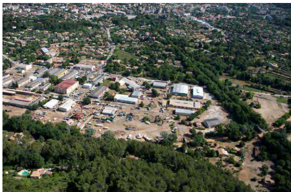
Photos 88 : Vues générales post crue – du pont de Lorgues à l'ancienne - Voie ferrée
