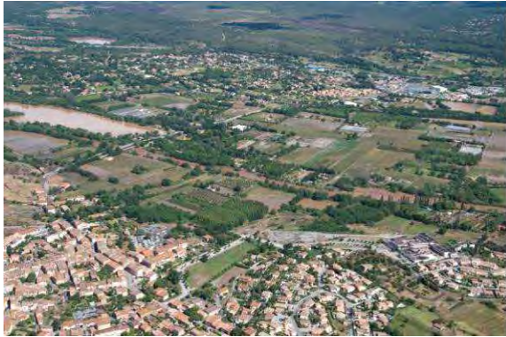
Photos 20 : L'Argens au niveau du pont de Roquebrune - Au fond secteur des Garillans - Post crue
