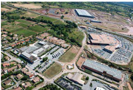
Photos 50 : Le Réal en amont de la RD7N et la ZAC des Bréguières au second plan - Post crue
