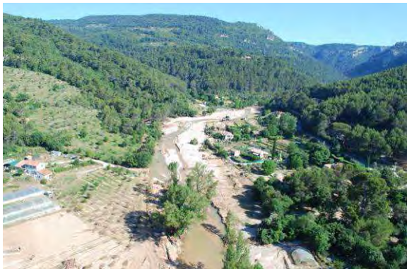
Photos 70 : La Nartuby secteur Granegone – Post Crue
