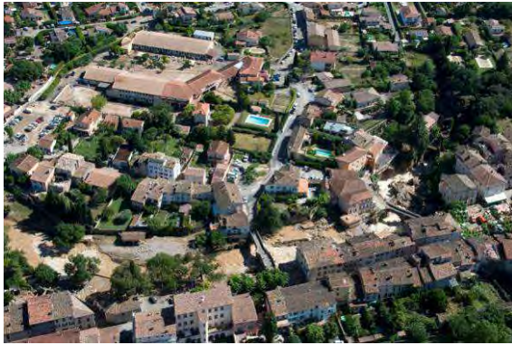
Photos 111 : Trans en Provence centre – Post Crue
