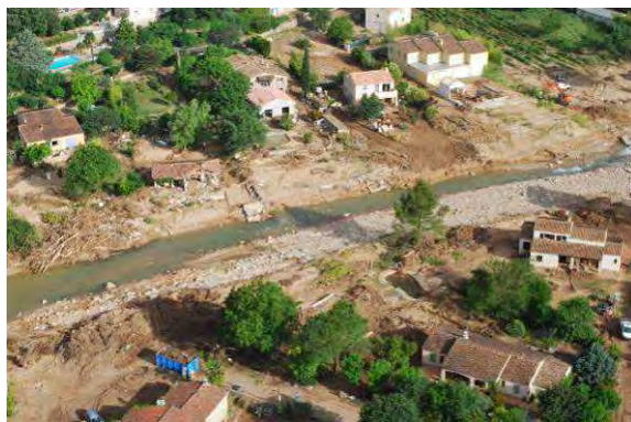
Photos 34 : Amont du Pont de la RD10 – Florièze à Taradeau - Post crue
