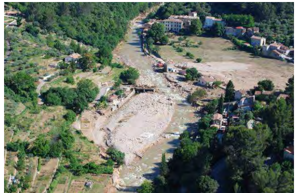
Photos 67 : La Nartuby à Rebouillon – Post Crue
