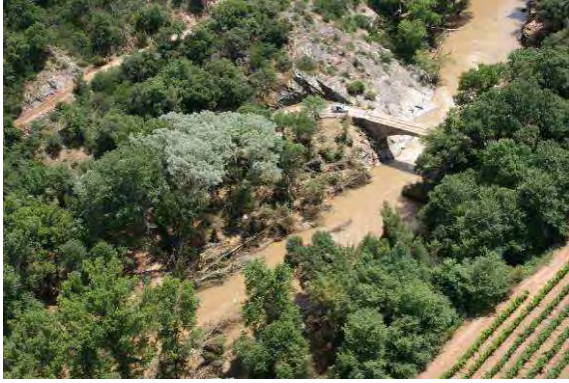
Photos 10 : Pont de la Tournavelle –Gorges de l'Argens en aval des Arcs – Post crue
