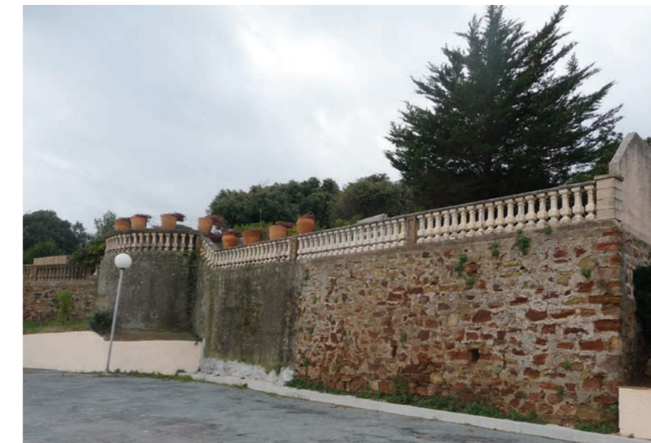
Soutènement du port de Saint-Aygulf
