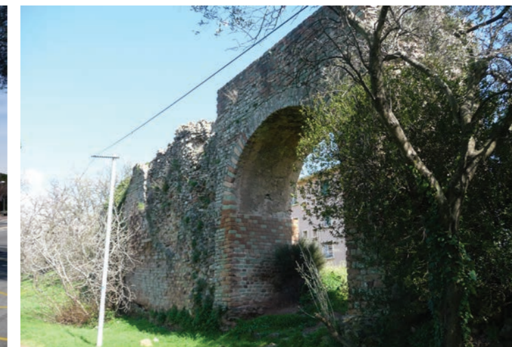
Le canal de l'aqueduc sur le rempart au Nord
