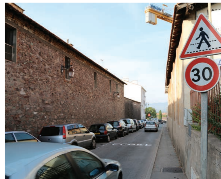
L'enceinte du XVI e s. rue Aubenas
