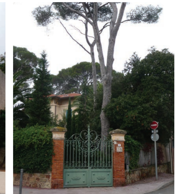
Clôture d'angle sur les avenues
