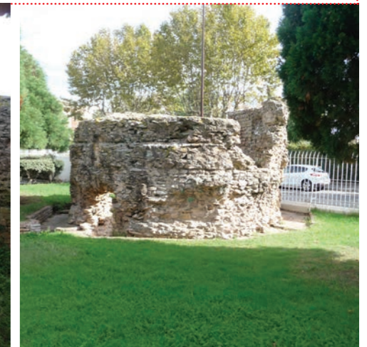
Maçonneries sans parement
