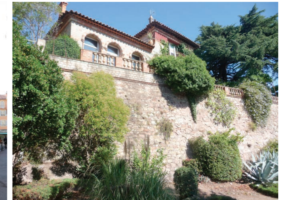
Soutènement de la Villa rue Edmond Poupe
