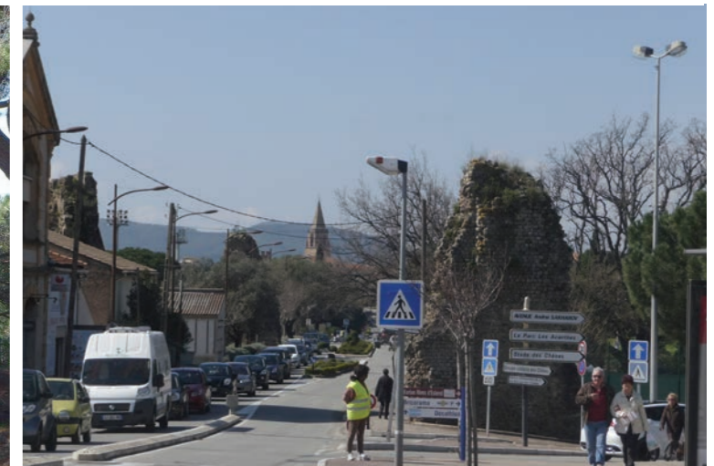
4 - Un pilier de l'aqueduc av. du 15° Corps d'Armée
