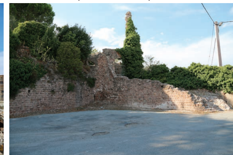
Vestiges de l'entrée Est de la Butte depuis le port
