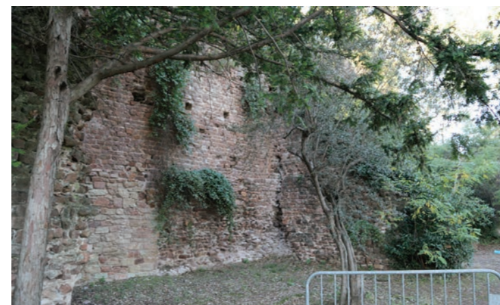
Le soutènement de la Plate-Forme
