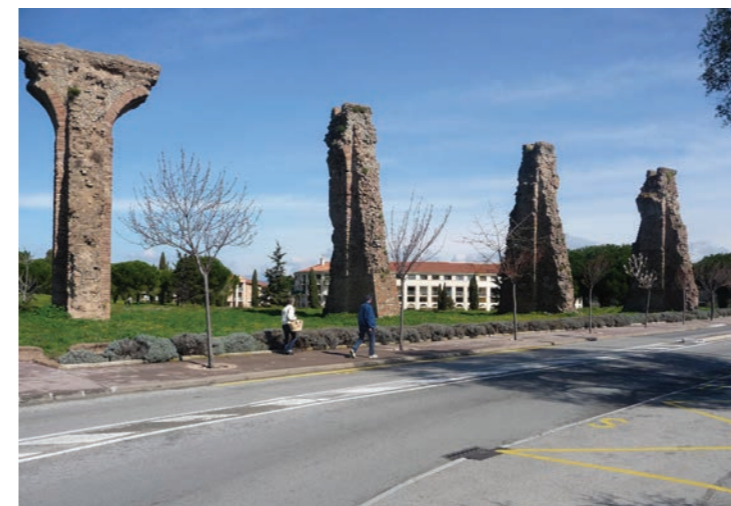
L'aqueduc avenue du 15 e Corps d'Armée
