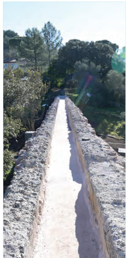
La partie haute de l'Aqueduc se nomme le specus: c'est le canal où l'eau coulait le long de l'Aqueduc. L'intérieur du conduit était couvert par une voûte.
