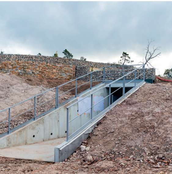
Construction du nouveau réservoir d'eau potable du Gargalon à Fréjus.
