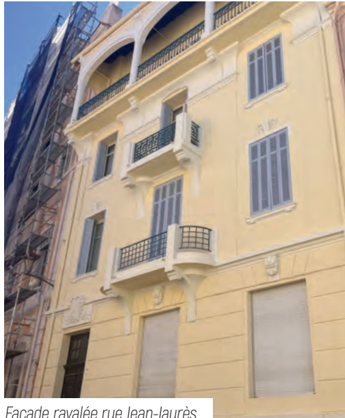
Façade ravalée rue Jean-Jaurès.
