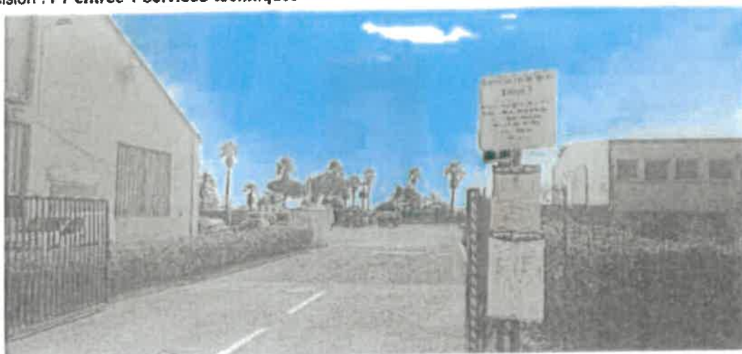
Photo N° 7 rattachée au rapport N°2023 000928 Précision : P7 entrée 1 services techniques
