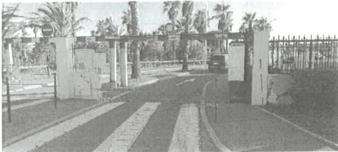
Photo N° 1 rattachée au rapport N°2023 000974 Précision : <Nouvelle photo>
