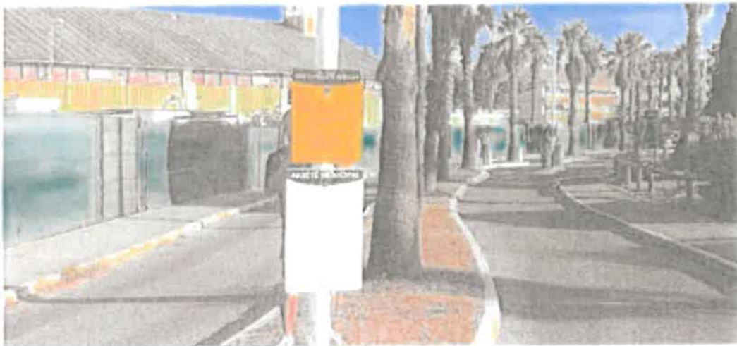
Photo N° 5 rattachée au rapport N°2023 000928 Précision : P5 voie d'accès principal au parking de la base
