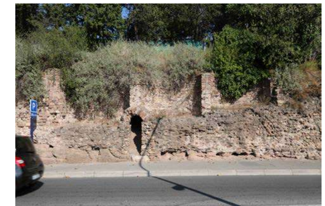
Murs de soutènement formant des niches le long de la Butte Saint Antoine
