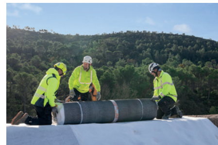
L'écrêteur de crue de l'Aspe lors d'une des dernières phases de travaux : la pause de la géomembrane.
