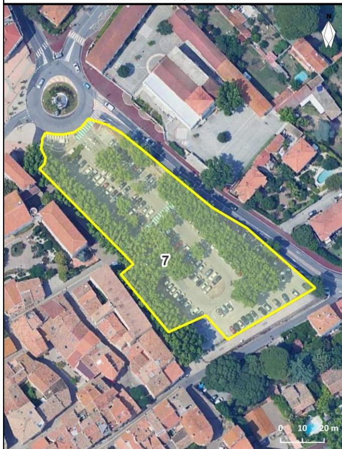
Parc de stationnement à ciel ouvert PAUL VERNET (181 places) situé à + de 1 km de la parcelle BD n° 478
