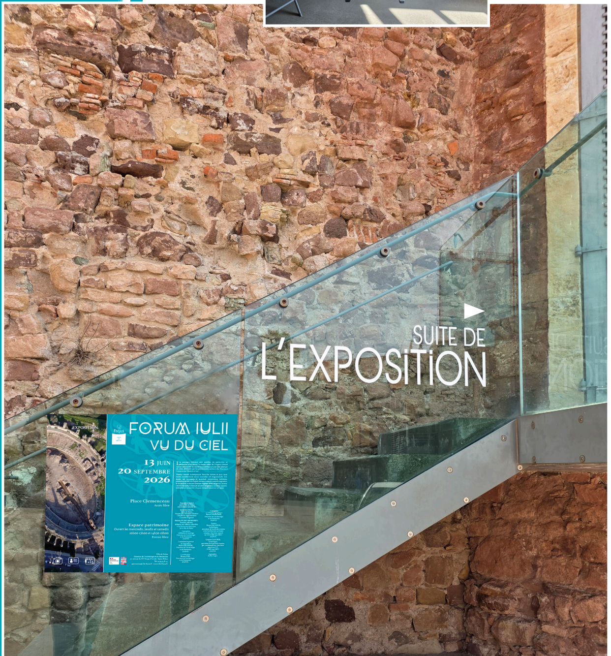
Illustration de l'habillage de la paroi de l'Espace Patrimoine
