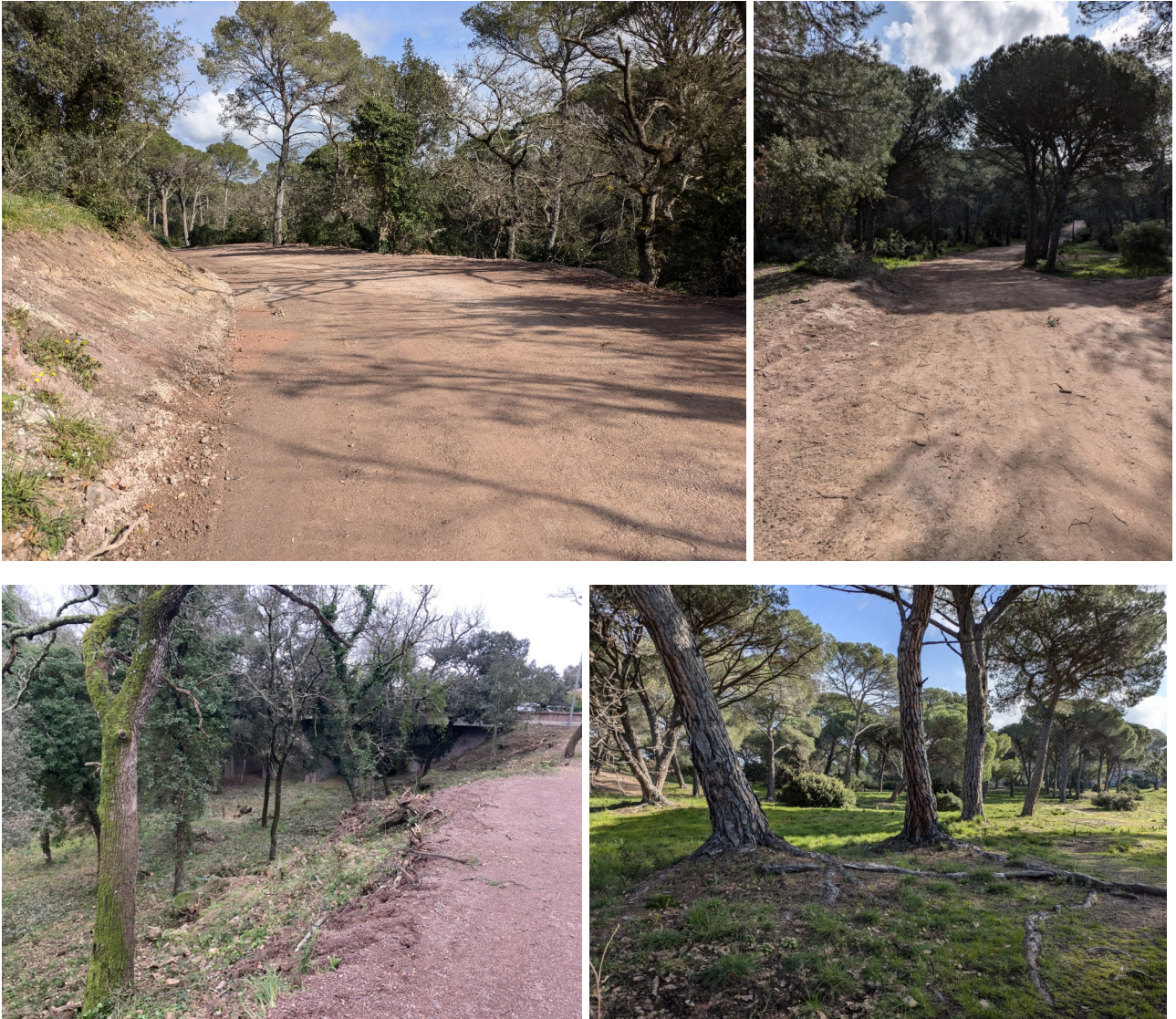
Photos des aménagements réalisés : piste réservée aux services de secours et d'incendie, et débroussaillage
