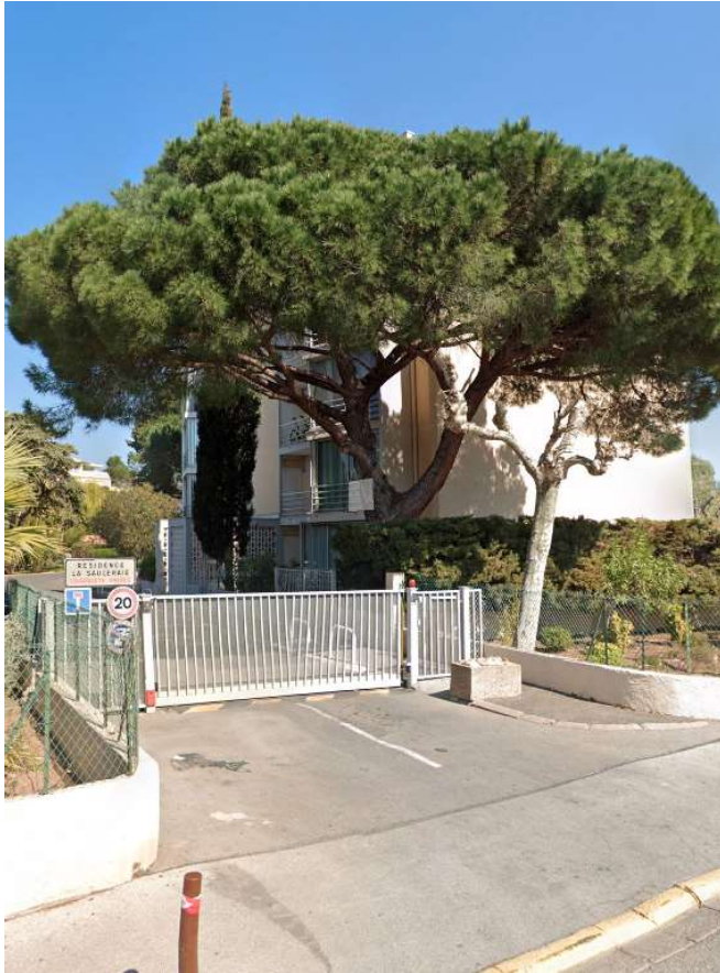
Photo 1 : vue générale bâtiment
