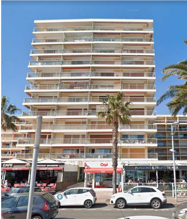
Photo 1 : vue générale bâtiment
